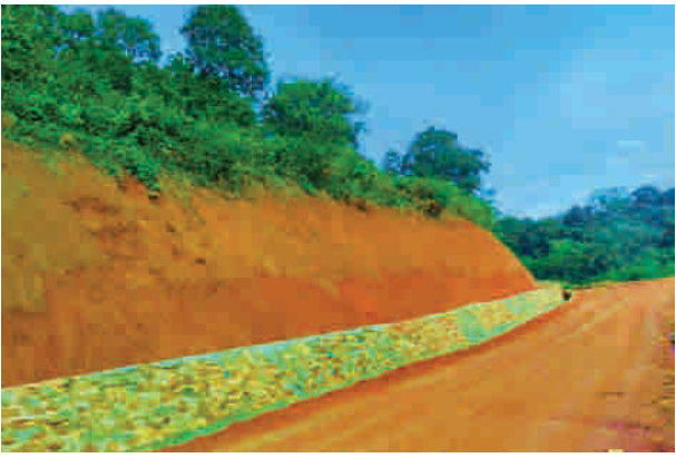
ချီဖွေမြို့နယ်၊ ၄မိုင်တပ်စခန်း-ဂျိတ်လွယ်-နဘုတ်စုစည်းလမ်း ပေါ်တွင် ကျောက်စီရေမြောင်း ၃၀၀၀ ပေ တည်ဆောက်ခြင်း
