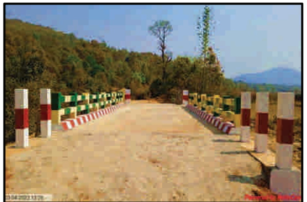
လဲချားမြို့နယ်၊ ကောင်းစံ ကျေးရွာနှင့်ဝမ်နောင် ကျေးရွာချင်းဆက် လမ်းပေါ်တွင် ၄၀ ပေ ကွန်ကရစ် တံတားတည်ဆောက်ခြင်း
