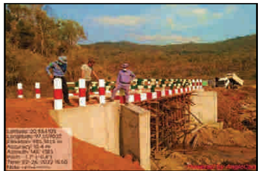
နမ့်စန်မြို့နယ်၊ နောင်စန့်-နောင်ဘိုလမ်း ၇/၄မိုင်လမ်းပေါ်တွင် ၃၅ ပေ ကွန်ကရစ်တံတားတည်ဆောက်ခြင်း
